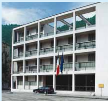
Ex Casa del Fascio
