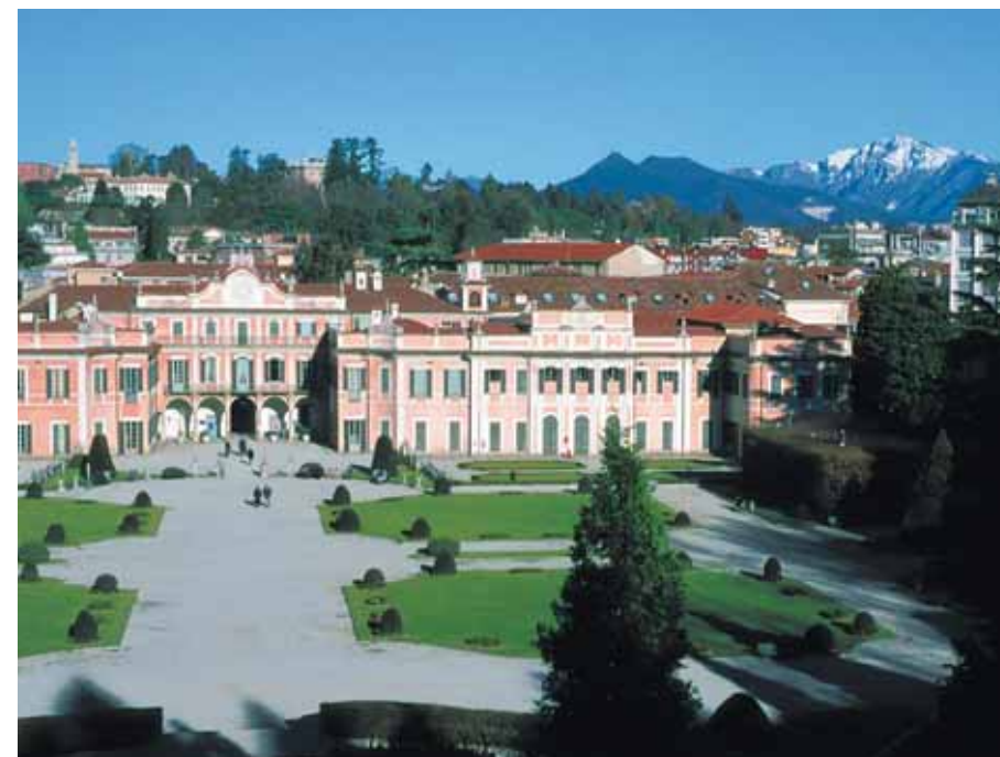
Palazzo Estense e parte dei giardini
